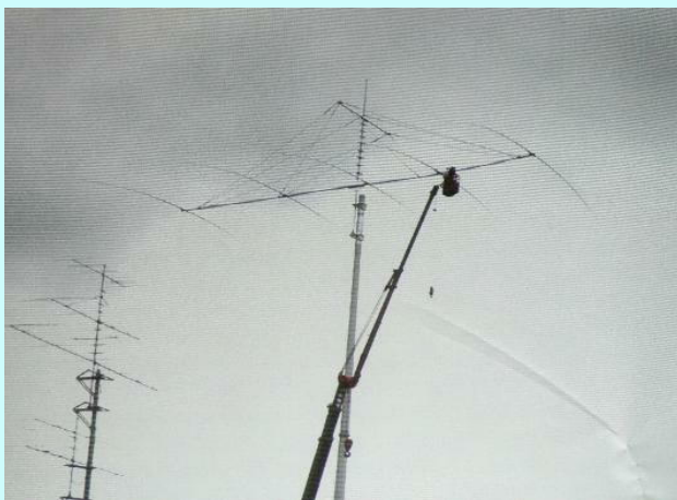
DXフォーラムで紹介された7MHz 5エレメント アンテナ1、タワー共に自作 by JH3NDG 右写真の右端が7MHz 5el. 左写真 アンテナ取り付け作業
