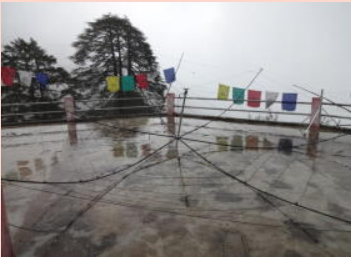
6本のエレメント共、同様に各環を通し給電棒に戻る。
