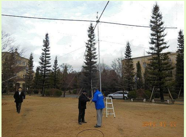
関西学院大学 三田キャンパスでのスパイダービーム組み立て
